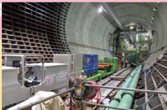
本線トンネル（南行）シールドマシン後方からの状況
