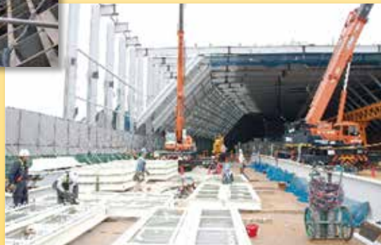
本線トンネル（北行）土砂ピットヤードの状況
